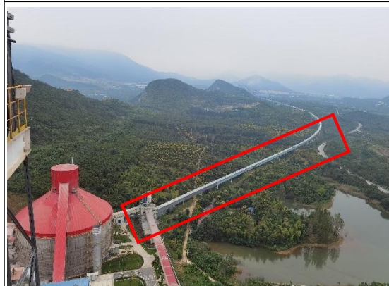
熟料发运输送皮带封闭廊道
