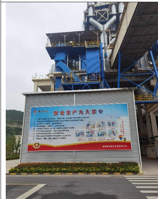
1#辊压机除尘器
