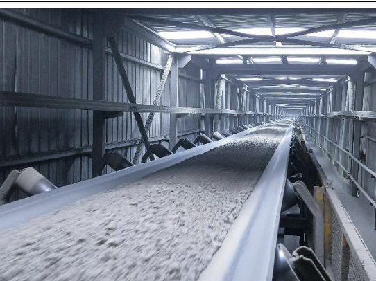
熟料发运输送皮带封闭廊道内部
