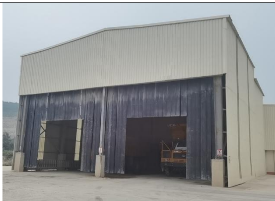
石灰石下料口整体封闭
