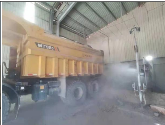
石灰石下料口内部设置自动干雾喷淋装置
