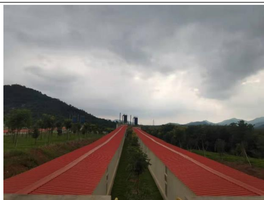
石灰石封闭式胶带输送机廊道
