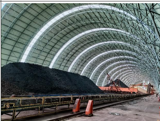
辅料及原煤均化库内部
