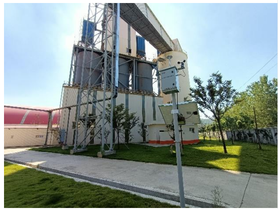
调配库西南侧微站
