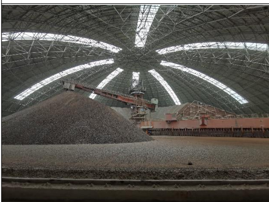
均化库顶卸料皮带已配套干雾喷淋装置
