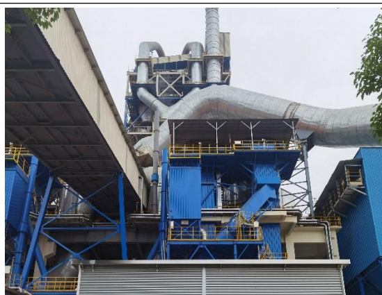
2#辊压机除尘器
