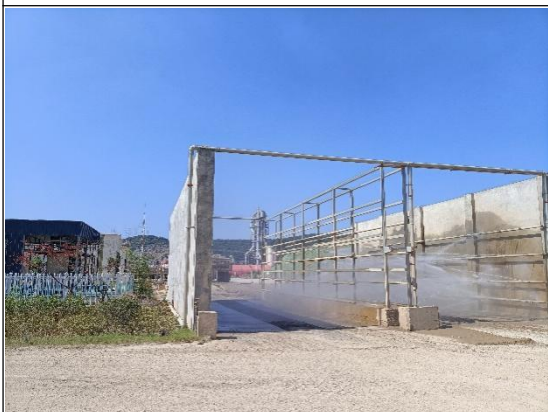
运矿道路已硬化并定期洒水
