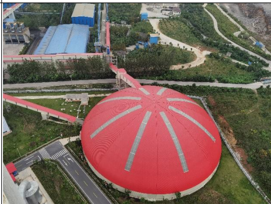
石灰石均化库为全封闭棚库
